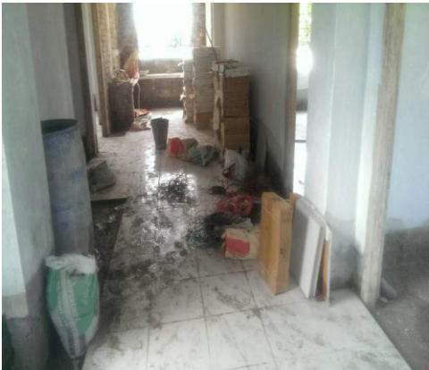
여름에도 계속된 공사는 막바지를 맞아서 복도 바닥 타일 공사가 한창이다. 다음주에 교실을 사용할 수 있길 간절히 소망한다 ~^^
